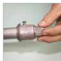
Destilar a Junta de Vedação para o Eletroduto até cobrir o conector.
