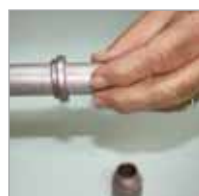
Introduzir a Junta de Vedação no Eletroduto.
