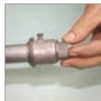
Deslizar a Junta de Vedação para o Eletroduto até cobrir o conector.
